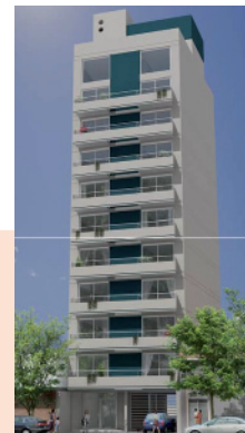
Guevara 483 Sup. Construida: 1520 m2
